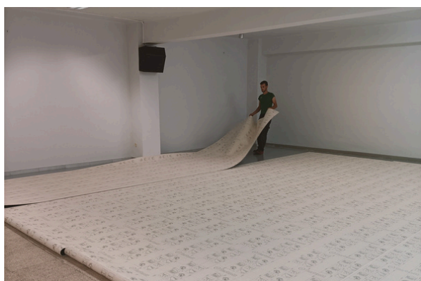
Col·locació del paviment tècnic de la nova sala de dansa i teatre del carrer Migdia
